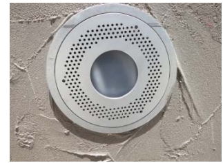
水中照明施工例
